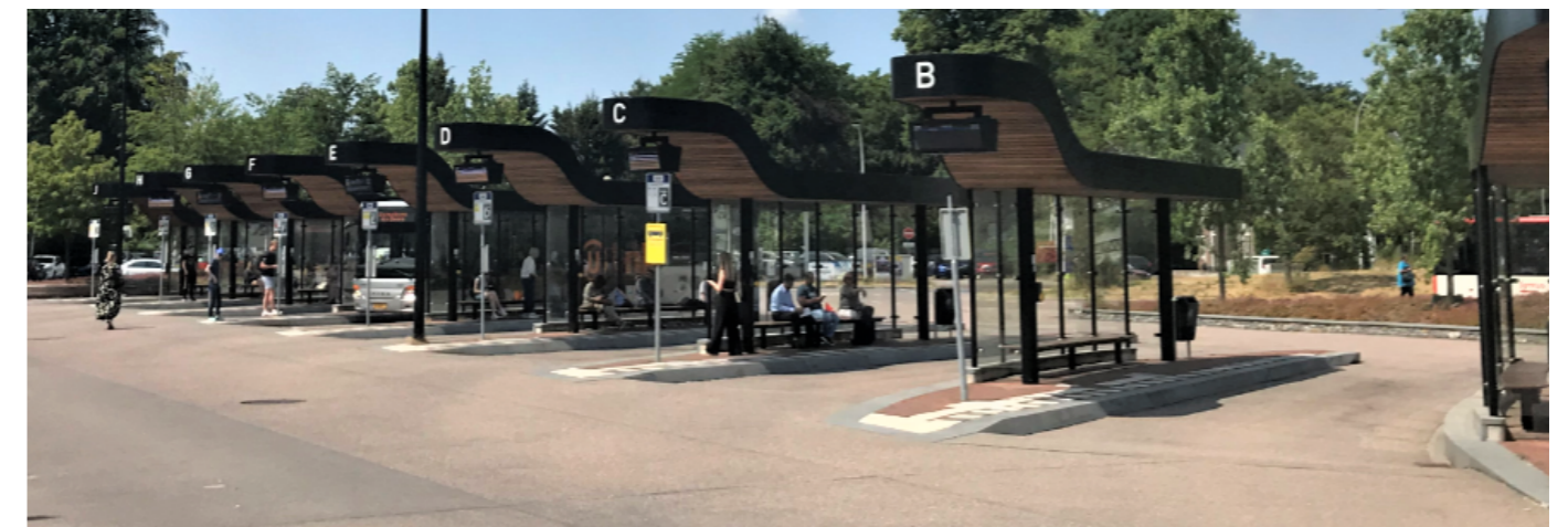
Station Driebergen Zeist
